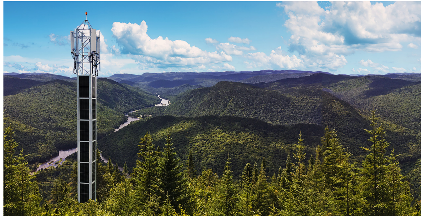
La SPT77 en el valle de Bras-du-Nord en Quebec, Canadá.
