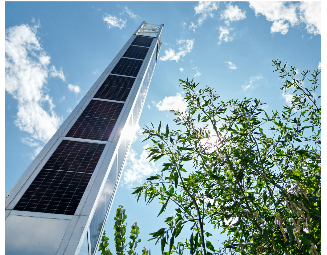
La SPT77 autoportante dans le quartier industriel de Mascouche.
